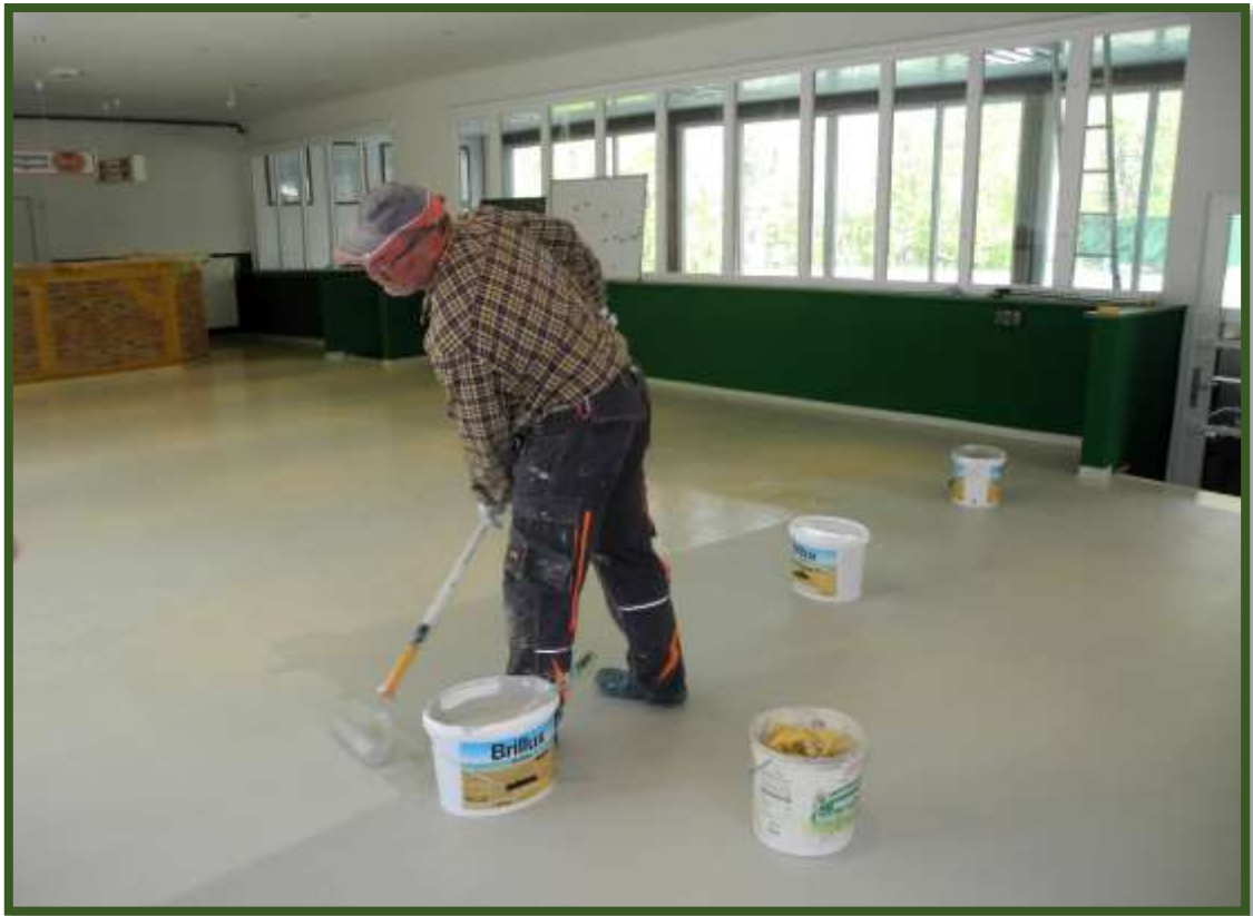
Rainer trägt den PU-Bodensiegel mit dem Maler-Roller auf.
